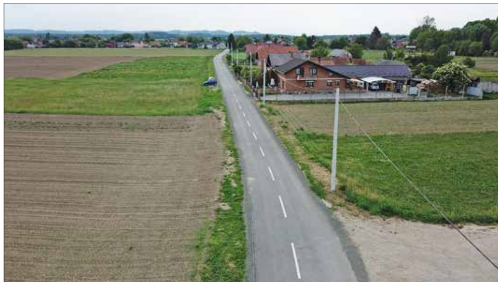
Nakon završetka rekonstrukcije, ulica je širine pet metara
