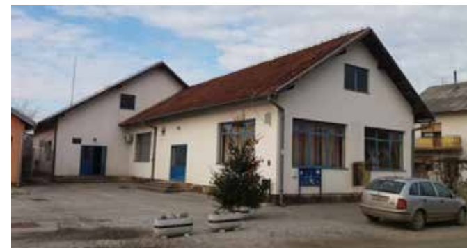
Društveni dom prije početka energetske obnove.
